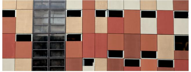
**2.100 módulos em concreto reforçado com fibra de vidro e colorido na massa formam a fachada de 28 mil metros quadrados.**
